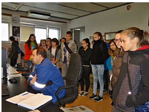
Velín úpravně vody
