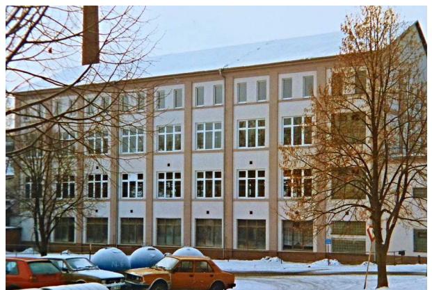
Foto opravené budovy z 8. 12. 1999
